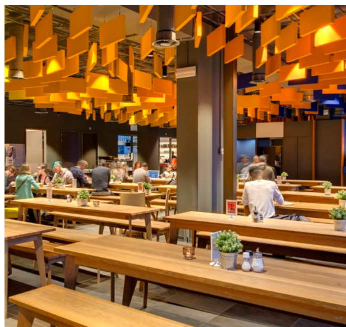
Proyecto: Meininger Hotel, Ámsterdam, Holanda / Arquitectos: Christian Sandor Tschersich, LAVA Architecture / Techos: Rockfon Contour® / Canto: Ac Perfilería: Chicago Metallic™ T24 Hook 2850 / Fotógrafo: Meininger Hotel, Ámsterdam
